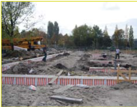
Begin november 2009: het beton voor het nieuwe bovenbouwgebouw is gegoten.
